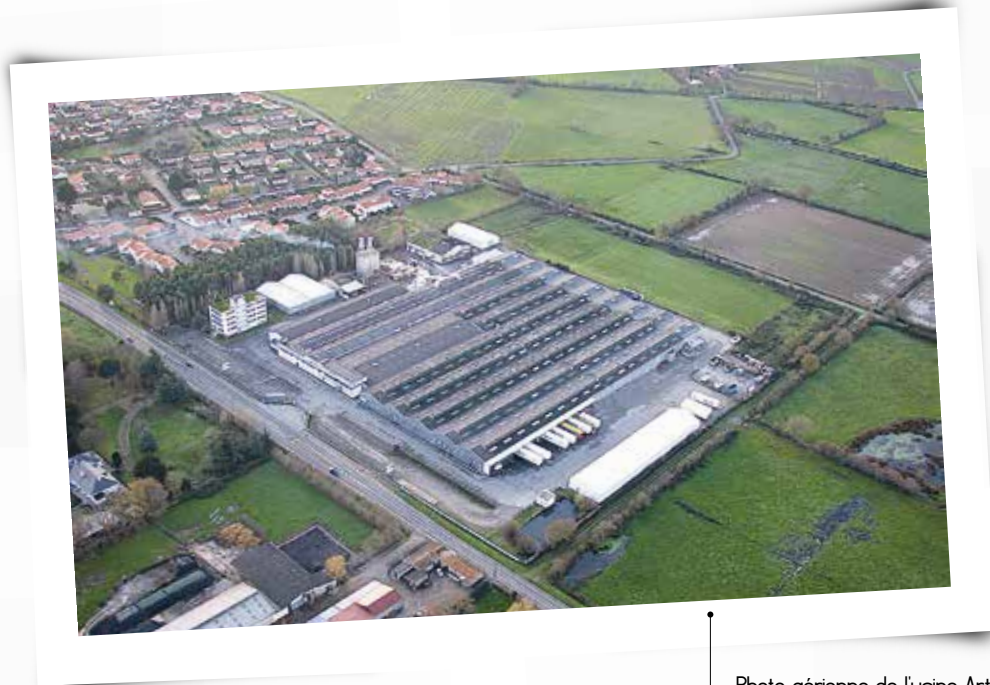
Photo aérienne de l'usine Arthur-Bonnet à St Philbert de Bouaine (85)
