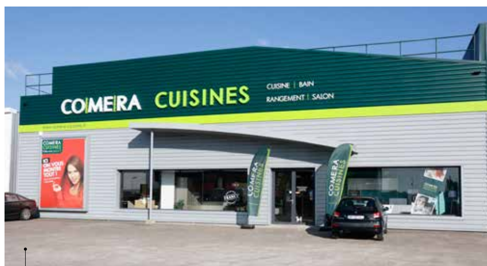
la façade, premier élément visuel avec l'univers de Comera Cuisines pour le consommateur
